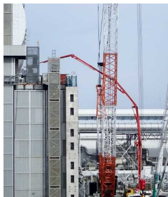
3号機 コンクリートポンプ車による注水訓練 (3月20日)
