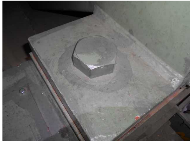
発電機本体基礎ボルト④
