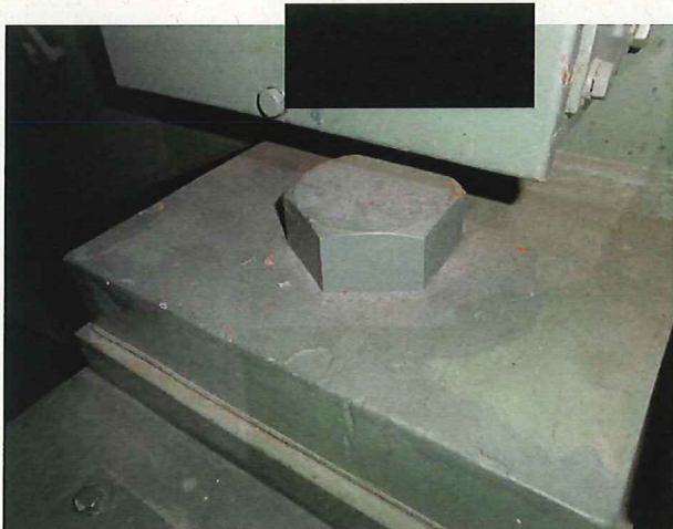
発電機本体基礎ボルト①
