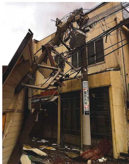
建物倒壊による電柱倒壊（千葉エリア）
