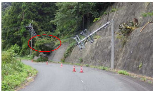
倒木による電柱倒壊（館山エリア）
