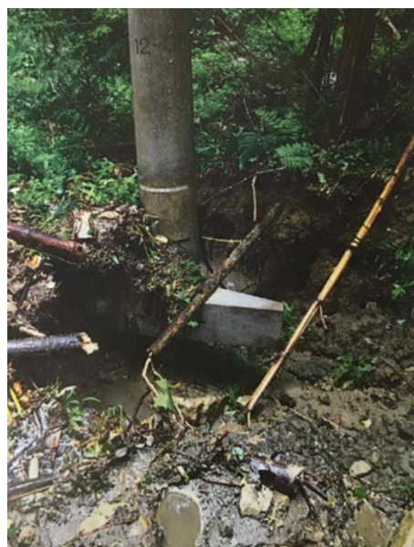
地盤影響による電柱傾斜（茂原エリア）
