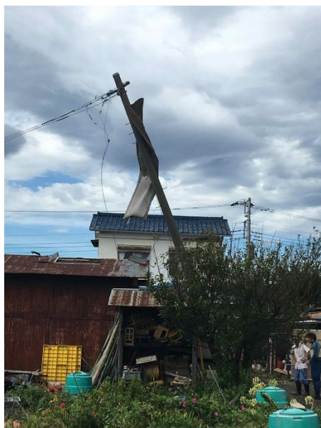
飛来物による電柱倒壊（相模原エリア）
