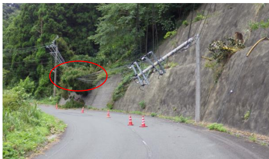
倒木による電柱倒壊（館山エリア）
