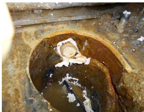
充填材による閉塞をした床ファンネル
