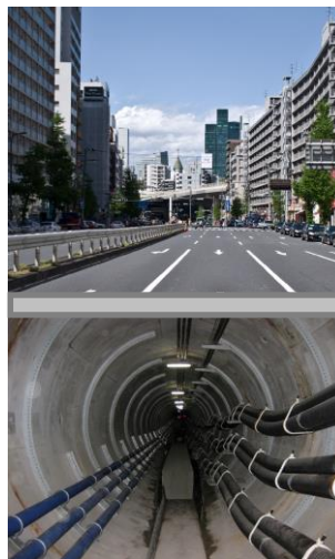
地中送電線（6万6,000ボルト） 6.2マイクロテスラ（62ミリガウス） 〈測定ポイント：地表0.5m, 1m, 1.5m ※値は3点の平均
