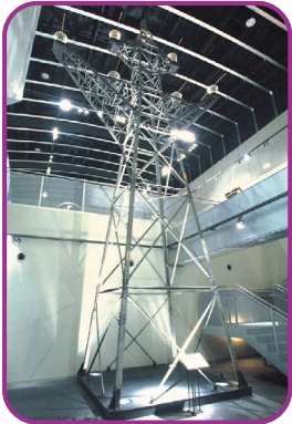
◀ 発電所でつくられた、 たくさんの電気を送る。 高い電圧(6万～50万 ボルト)
