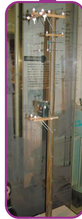
◀ 電気を家まで送る。 低い電圧(100～6千ボルト)
