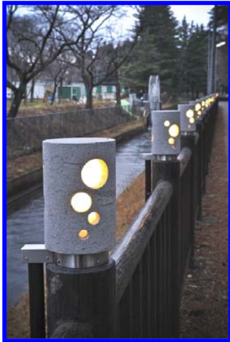
歩道の擬木柵上のLED照明(43W LED)
