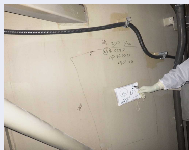
②格納容器の壁
