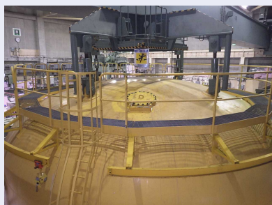
①格納容器上蓋部
