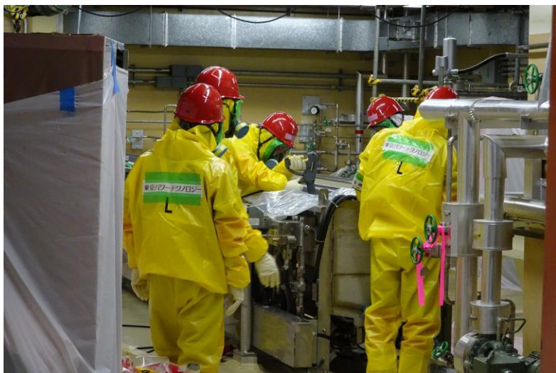
1号炉除染作業
