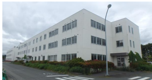
協力企業棟の解体前
