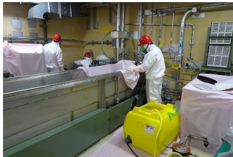
3号炉除染作業
