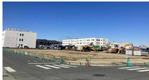
協力企業棟の解体後
