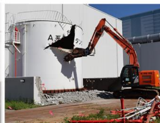
上：軽油タンクの解体撤去作業
