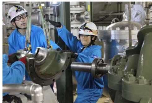
ポンプ軸受カバーの組み立てを行う所員
