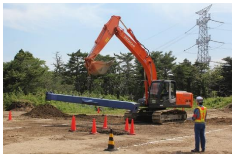
ガレキに見立てた鉄骨の撤去
