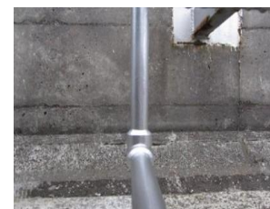
交換した新品の配管
