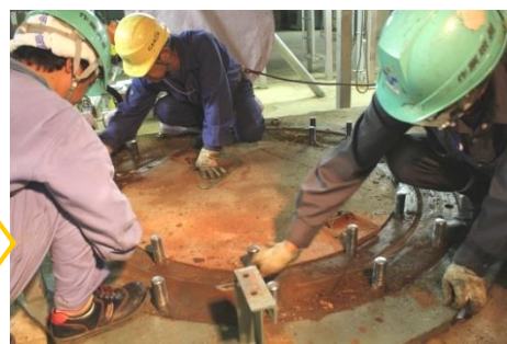
海水ポンプ基礎部の手入れ
