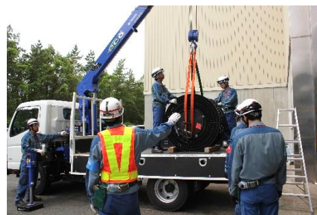
ケーブルドラムの積み込み
