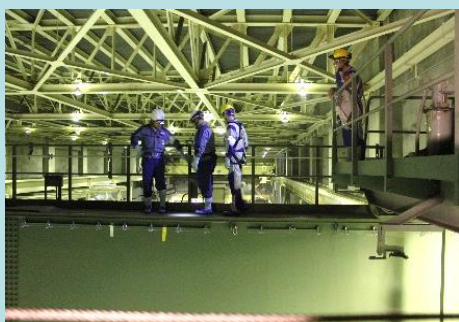
高所作業における安全確保状況の確認
