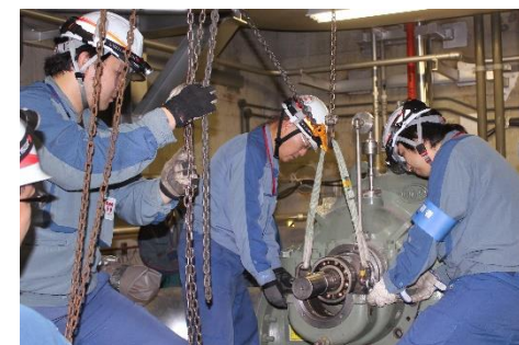
ポンプ軸受カバーの組み立て
