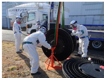
ケーブルドラムの積み下ろし
