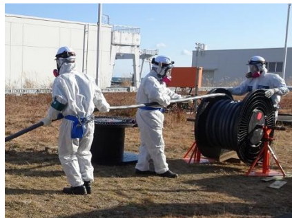
ケーブル敷設
