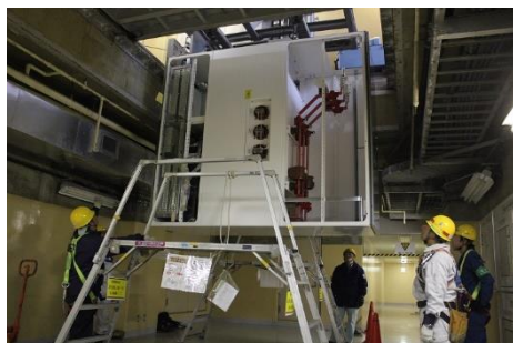
昇降装置による電源盤の吊り下ろし
