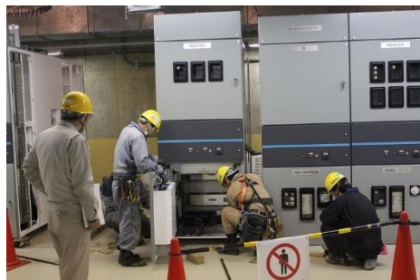
電源盤の据え付け
