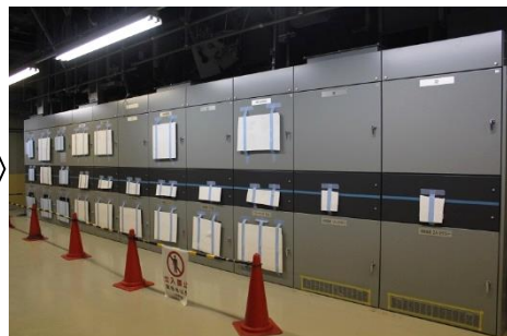
取り替えた後の電源盤
