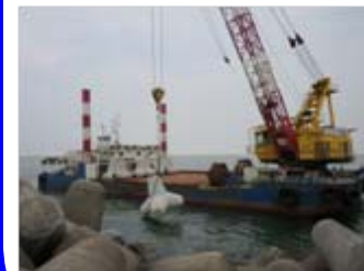
消波ブロックの設置（海上）
