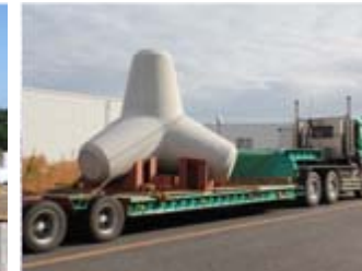
32tトレーラーによる消波ブロックの運搬
