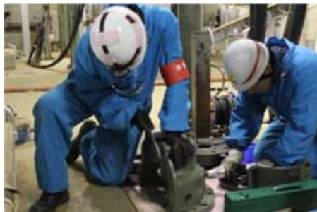
軸受のカバーを点検・手入れしている様子
