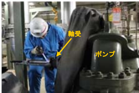
軸受を取り外すため、軸受をバーナーで加熱している様子
