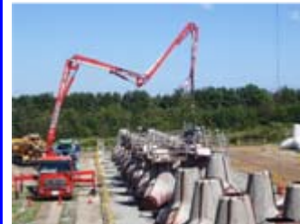
当所北側高台における消波ブロック(8t、12.5t、16t、25t)の製作
