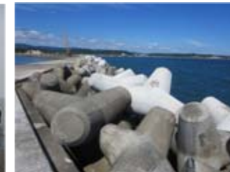
消波ブロック設置後の様子
