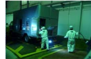
電源車からのケーブル引き出し
