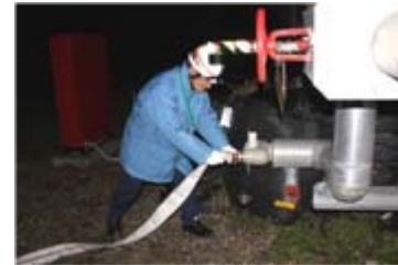
原子炉建屋送水口への消防ホース接続
