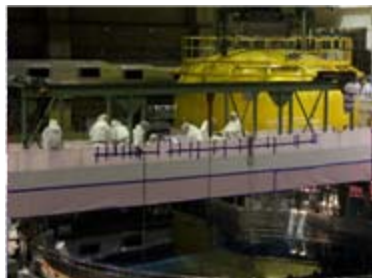
作業用台車上での点検作業の様子 （平成25年12月13日撮影）
