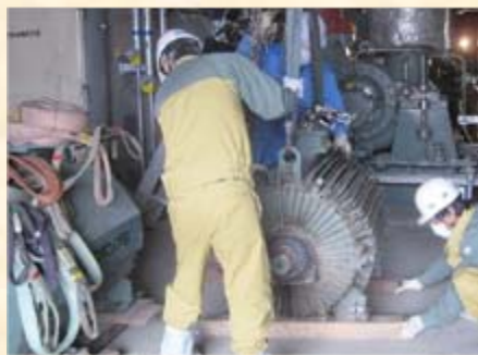
モータ取替の様子（震災時）
