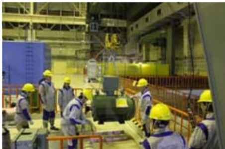
クレーンでのモータの吊り上げ、吊り降ろしの様子
