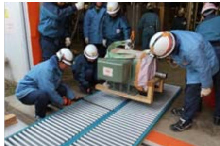
モータを移動している様子
