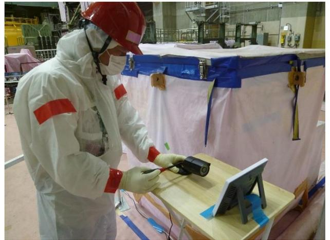
原子炉建屋6階燃料プールエリアへ燃料プールの温度上昇確認用の温度と湿度を確認する遠隔監視カメラを設置
