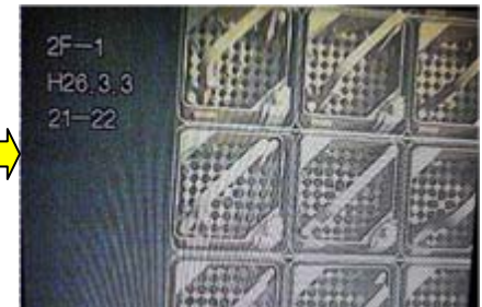
燃料集合体が収まっている状態の 使用済燃料貯蔵ラック
