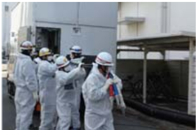
電源車からのケーブル引き出し
