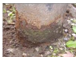
金属柱地際腐食（例）
