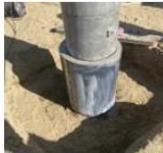
延命化工法（地際補強）
