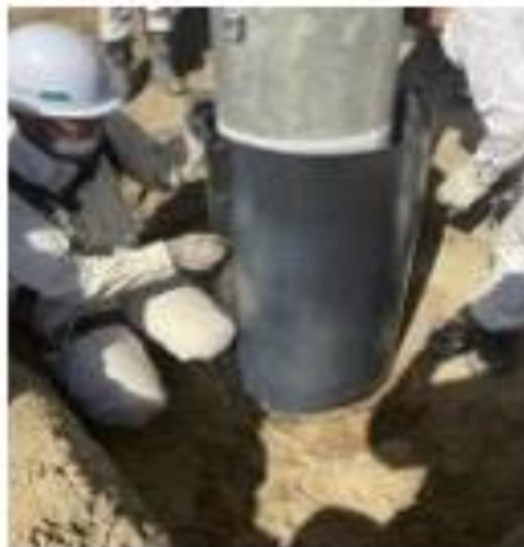
延命化工法（地際補強）
