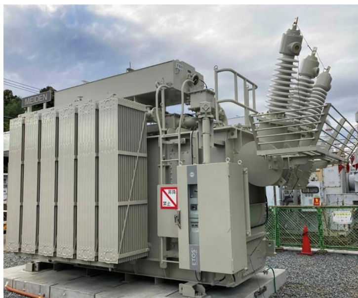
植物油（パームヤシ）を使用した電力用変圧器 [岩富変電所(千葉県佐倉市)]
