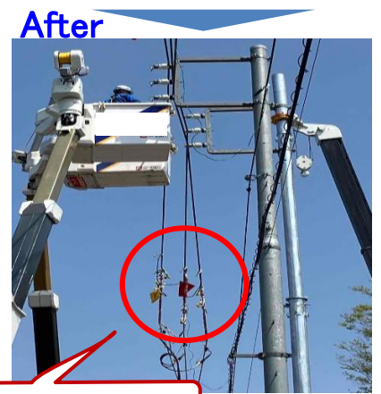
隔線器による線間距離確保
