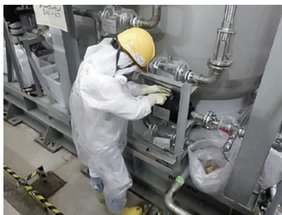
吸着材の逆洗作業
