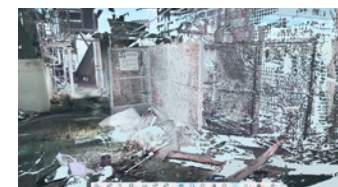
3号機の原子炉建屋内調査
