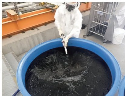
吸着材の交換作業
