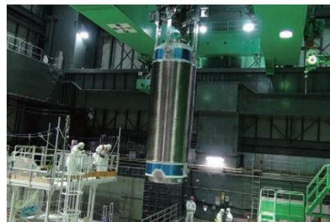
共用プールへのキャスク(燃料等を貯蔵・運搬する金属製の容器)の移動
