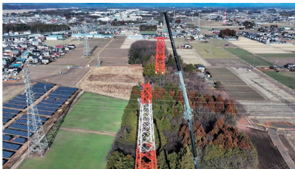
高経年化した鉄塔の更新工事
