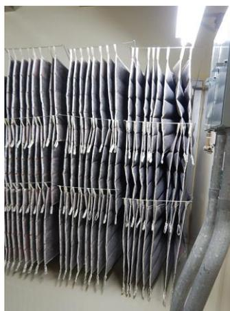
図 41-1-12：6号炉原子炉建屋3階 非常用ディーゼル発電機(B) エアフィルタ室の概要
