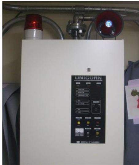
図 41-1-33 : 全域ガス消火設備の職員退避警報装置の例
