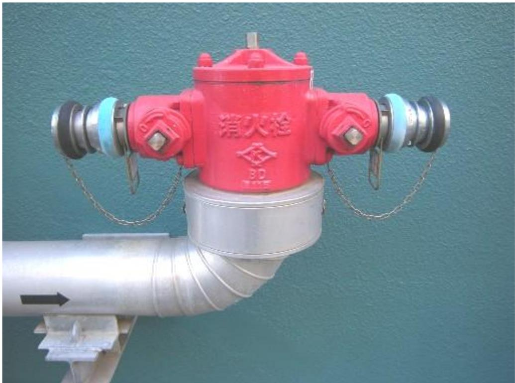
図 41-1-38 : 不凍式消火栓の設置状況
