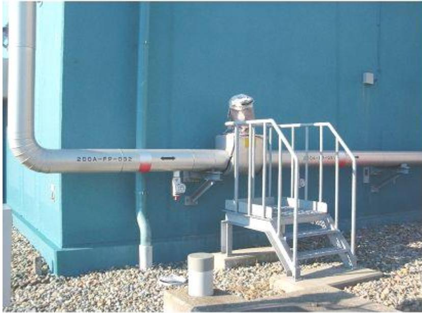
図 41-1-37 : 屋外消火配管への保温材設置状況
