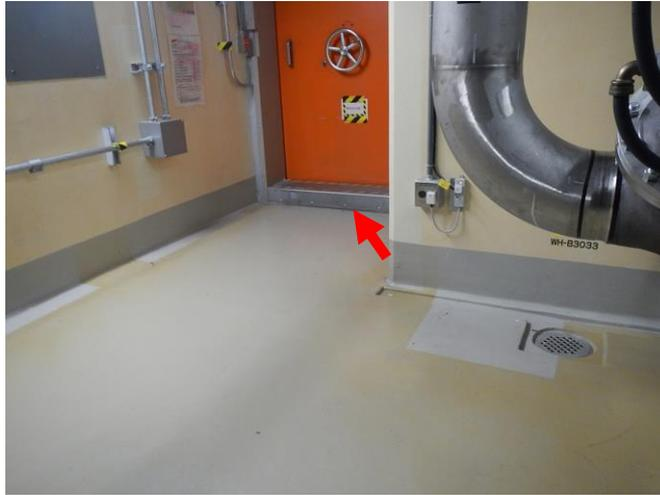
図 41-1-2 : 堰による拡大防止対策概要図
