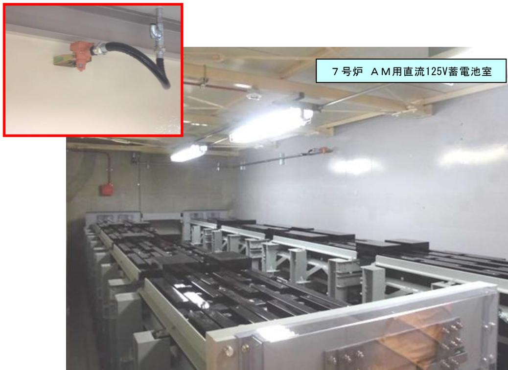
図 41-1-4 : 蓄電池室内の水素濃度検出器設置状況
