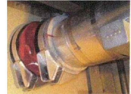
配管貫通部止水処置
