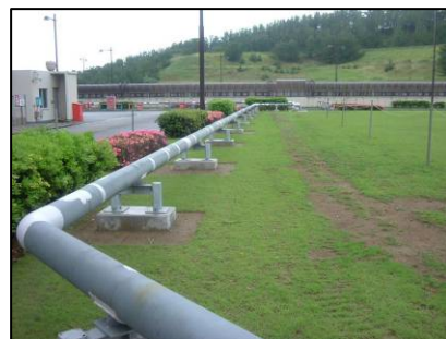
消火配管の地上化
