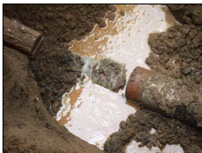
埋設消火配管の損傷
