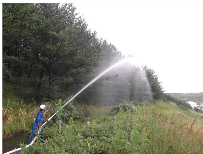
写真3 散水エリアAにおける散水状況
