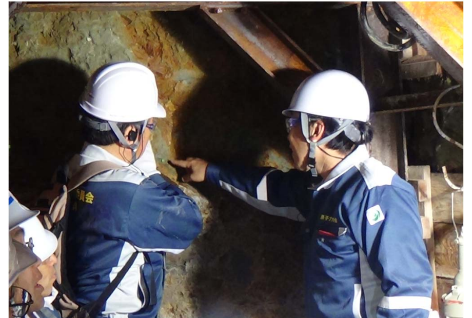
立坑調査状況 [10月31日]
