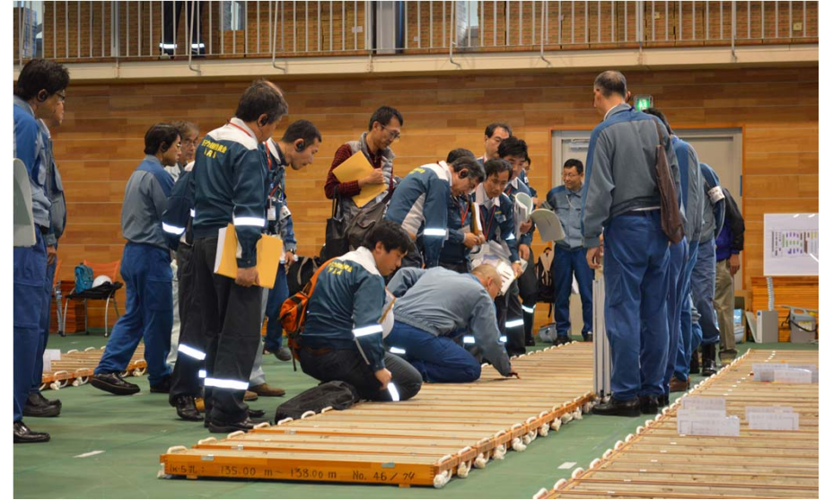
体育館でのボーリング調査 [10月30日]
