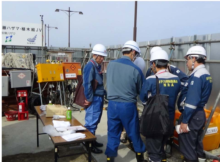
立坑調査状況 [10月31日]
