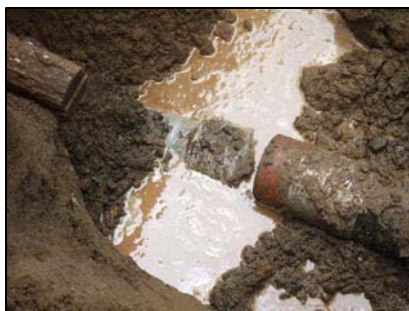
埋設消火配管の損傷
