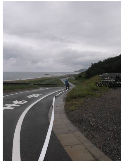
写真2 ホース展開状況
