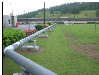
消火配管の地上化
