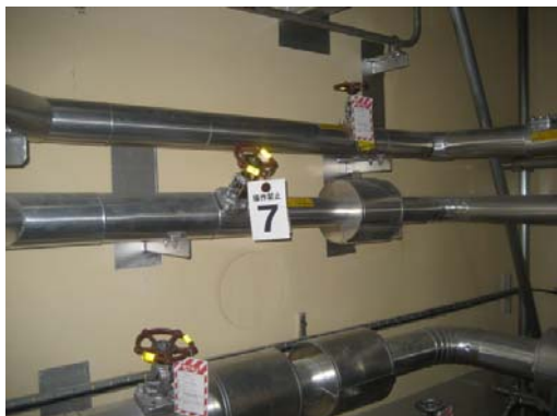
作業エリア（RHRポンプ室）
