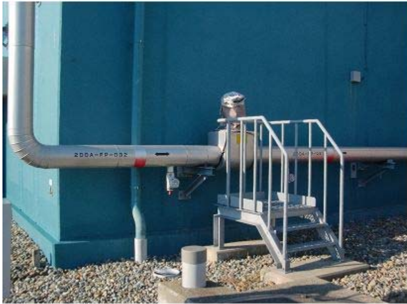
図 1-23 : 屋外消火配管への保温材設置状況
