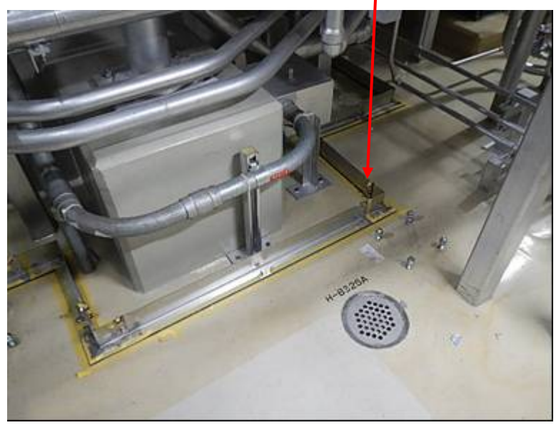
図 1 : 堰の設置状況
