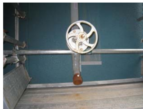
専用注水配管送水口
