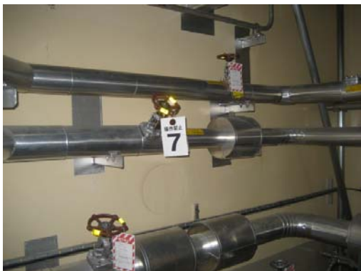
作業エリア（RHRポンプ室）
