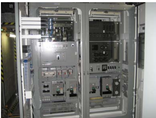
同時投入防止用切替盤
