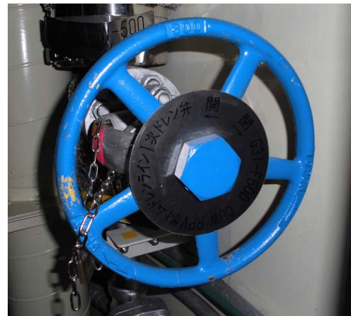
KK7原子炉压力容器ドレン弁
