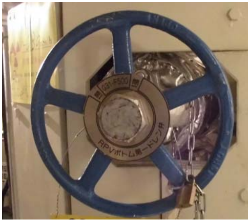
KK6原子炉压力容器ドレン弁
