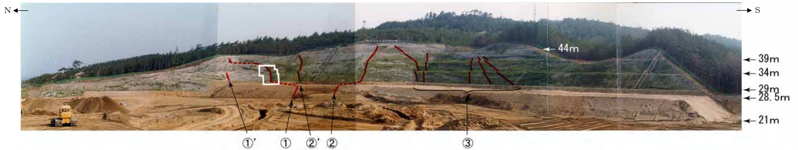
5号炉周辺斜面全景
