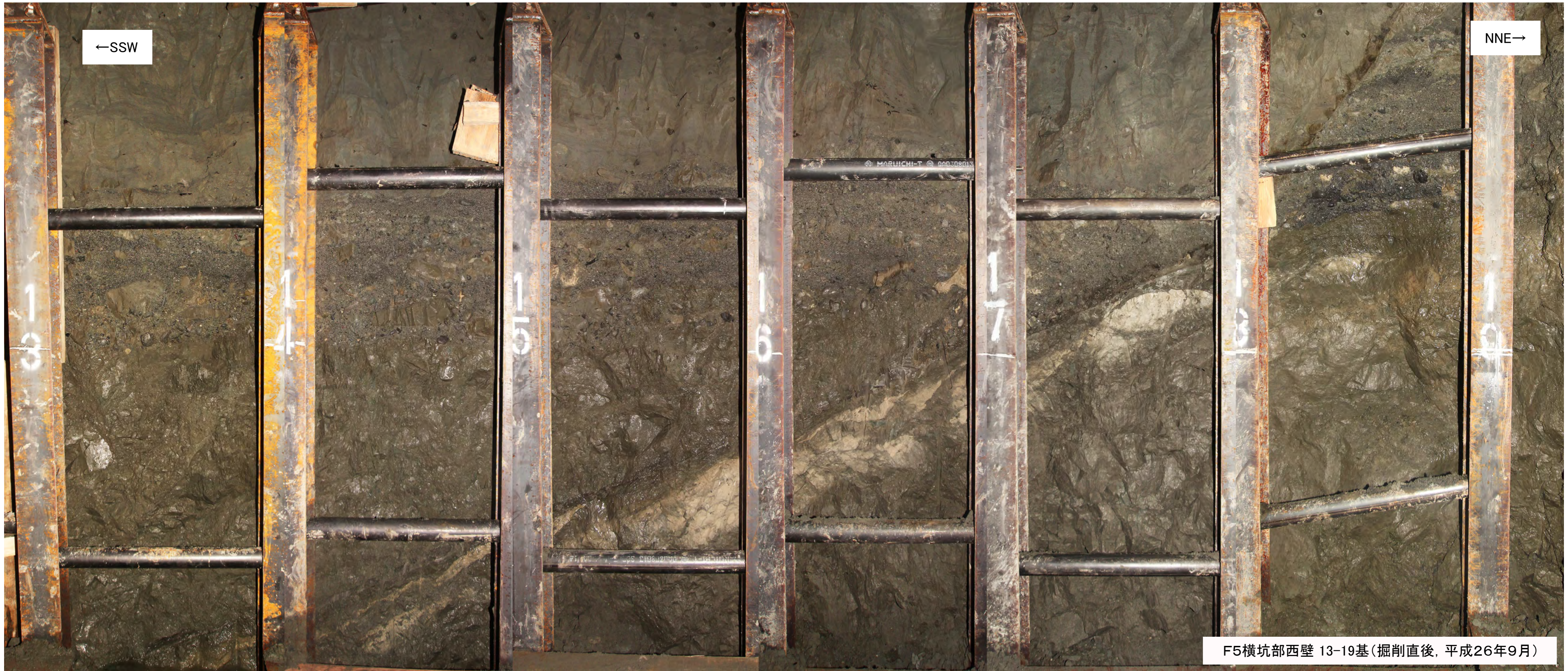
F5断層先端部の性状の分析(1) F5横坑部西壁 13-19基(掘削直後, 平成26年9月)
