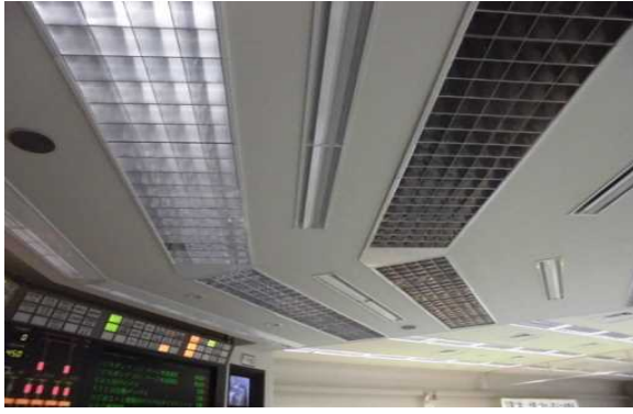
中央制御室照明
