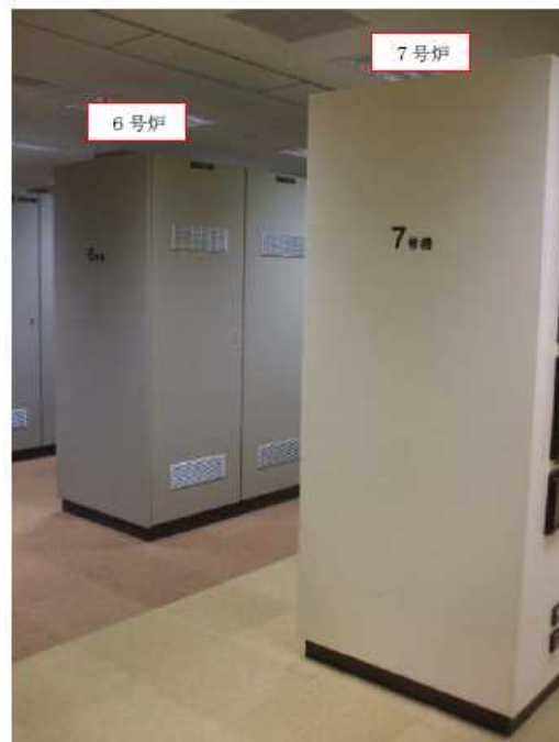
第 2.2.5-2 図 制御盤（裏盤）の色別管理
