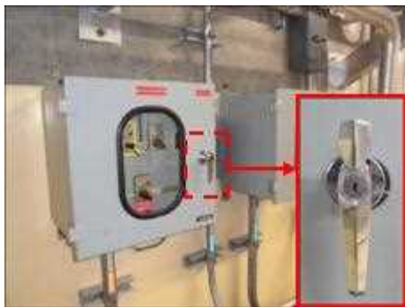
制御盤の施錠
