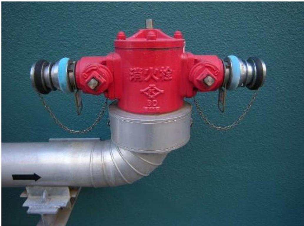
図 1-29 : 不凍式消火栓の設置状況
