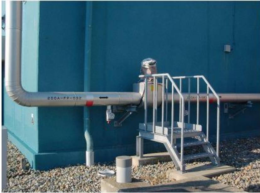
図 1-28 : 屋外消火配管への保温材設置状況
