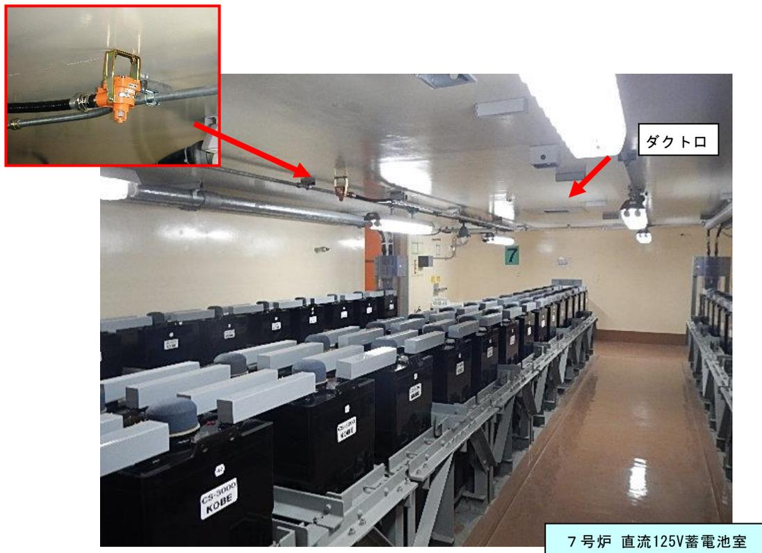
図 1-6 : 蓄電池室内の水素検出器設置状況
