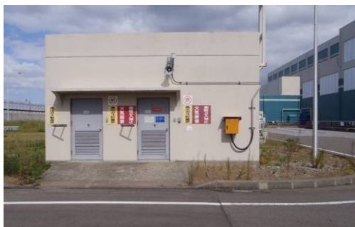
発電機用水素ガスポンプ建屋（6号炉）
