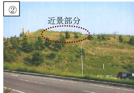
大湊側高台保管場所西側斜面（遠景）
