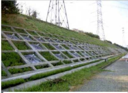
超高圧開閉所東側法面
