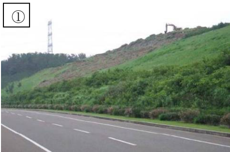
土捨場北側斜面（近景）
