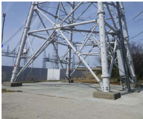
新新潟幹線 No. 1 送電鉄塔
