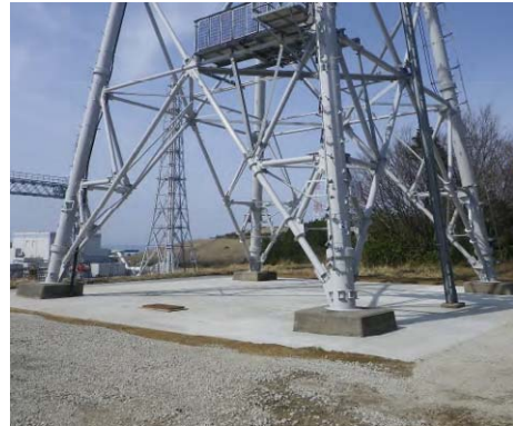
南新潟幹線 No. 1 送電鉄塔
