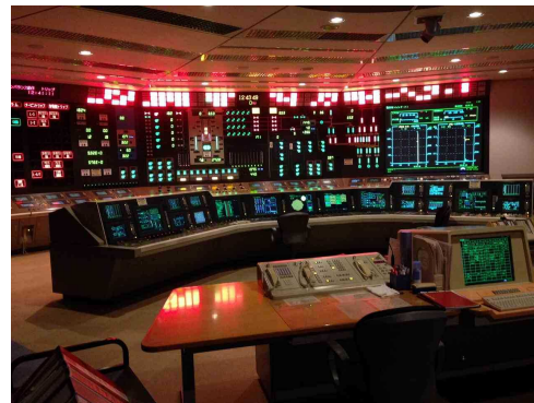
(直流非常灯点灯状態)
