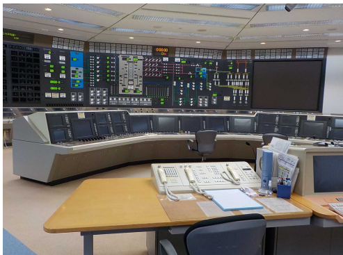
(通常点灯状態)
