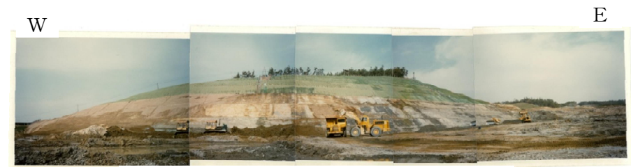
1号炉北側法面写真（標高5m～15m）
