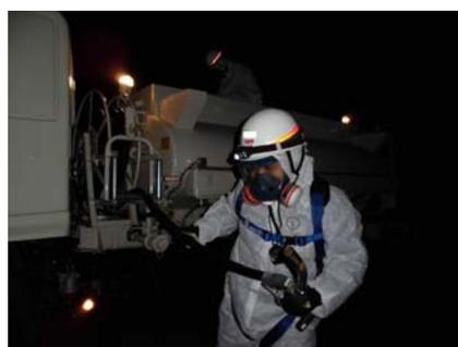
図3 放射線防護具類を着用した状態での作業状況
