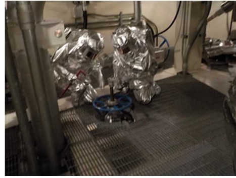
②現場手動弁隔離操作 (防護具着用)
