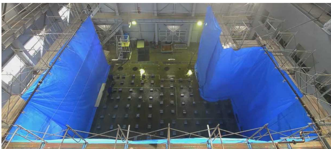
図8 スプレー前の状況（スプレー量：0m 3 /h）
