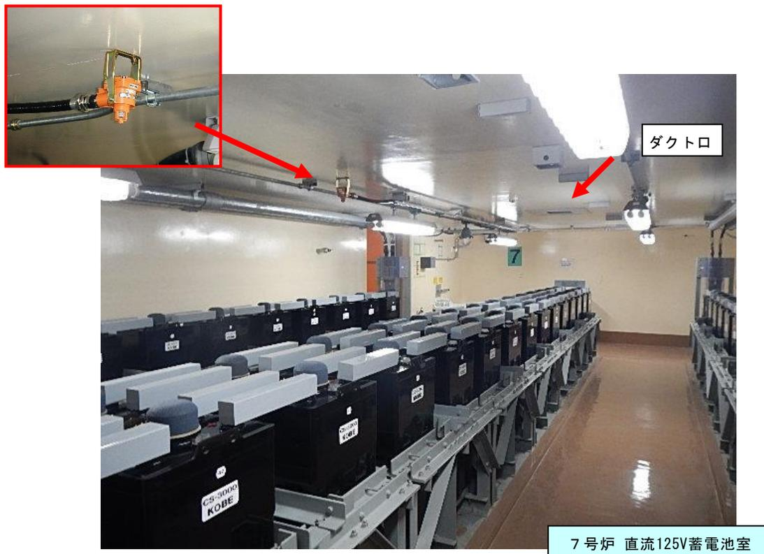
図 1-7 : 蓄電池室内の水素検出器設置状況
