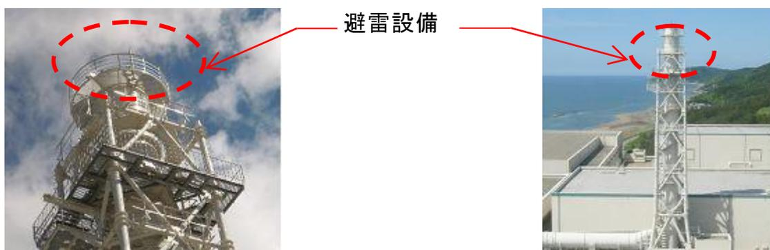
図 1-15：避雷設備の設置例（排気筒）
