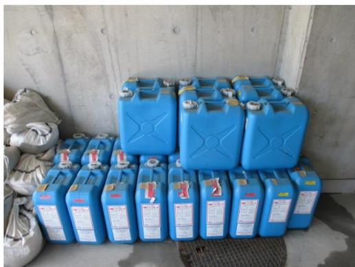
図4 泡消火薬剤ポリタンク 500 リットル
