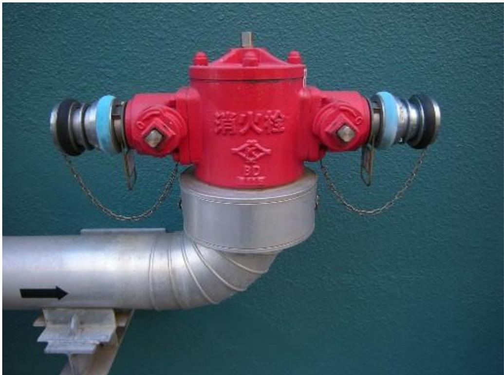
図 1-30 : 不凍式消火栓の設置状況
