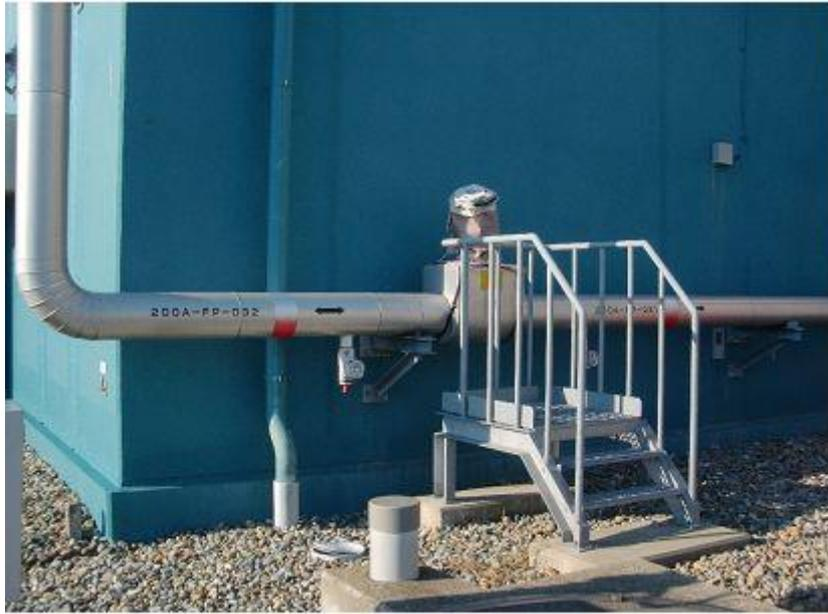
図 1-29 : 屋外消火配管への保温材設置状況
