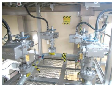
電動弁及び可とう電線管
