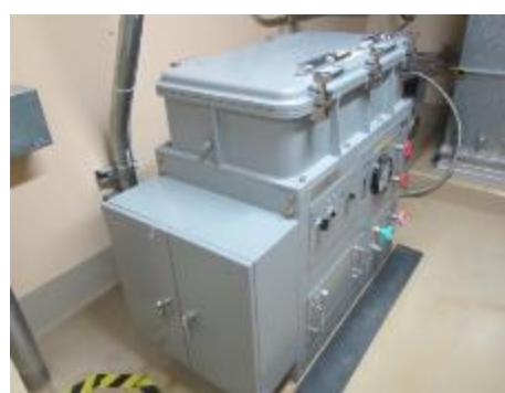
ダストサンプラ及び可とう電線管
