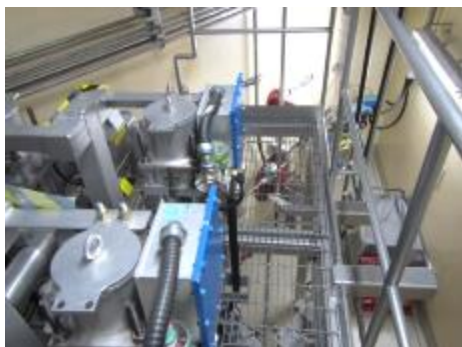
空気作動弁及び可とう電線管
