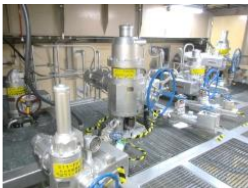
電動弁及び可とう電線管
