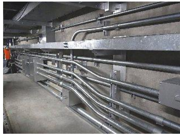
ケーブルトレイ，電線管の例
