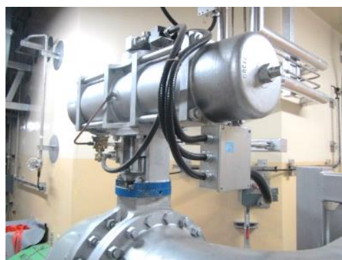
空気作動弁及び可とう電線管
