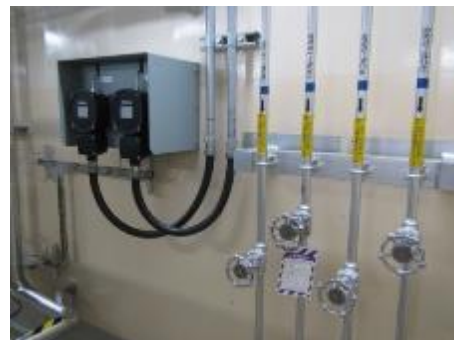
計器及び可とう電線管
