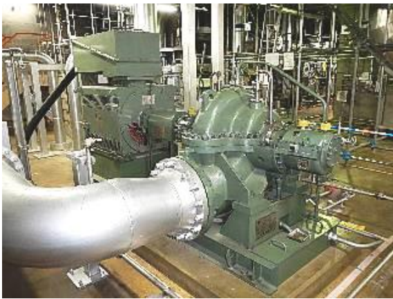
ポンプ，配管，支持構造物の例
