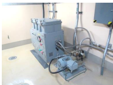
ダストサンプラ 及び可とう電線管
