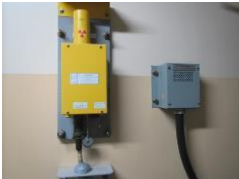
エリアモニタ及び可とう電線管
