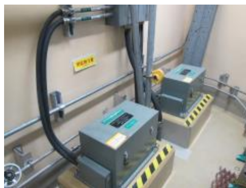
地震観測装置及び可とう電線管
