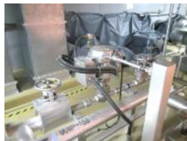
空気作動弁及び可とう電線管
