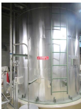
サージタンク
