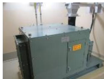
電動機及び可とう電線管
