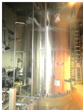
サージタンク
