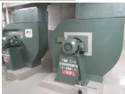
送風機、電動機及び可とう電線管
