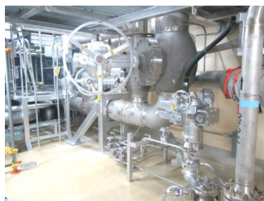
電動弁及び可とう電線管
