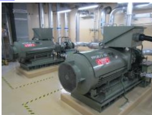
ポンプ及び可とう電線管
