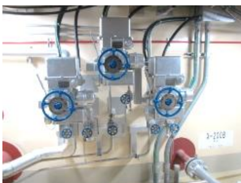
電動弁及び可とう電線管
