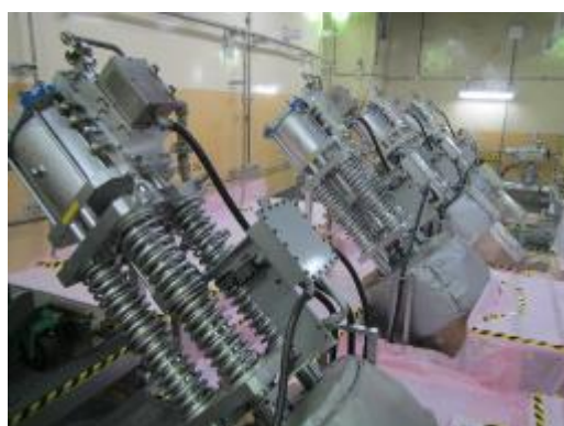
主蒸気隔離弁
