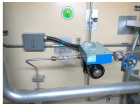
電磁弁及び可とう電線管
