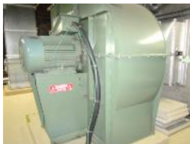
電動機及び可とう電線管
