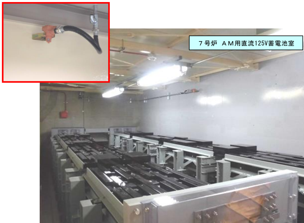
図 10-4 : 蓄電池室内の水素検出器設置状況
