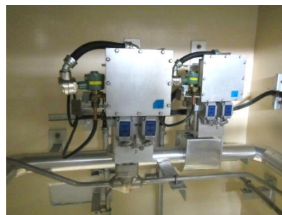
空気作動弁及び可とう電線管
