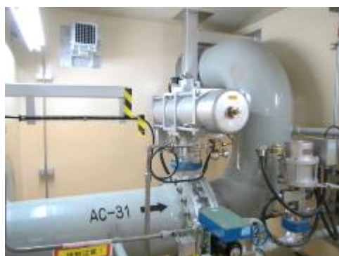
空気作動弁及び可とう電線管
