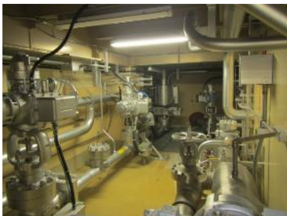
電動弁及び可とう電線管
