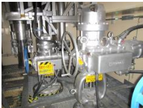
電動弁及び可とう電線管
