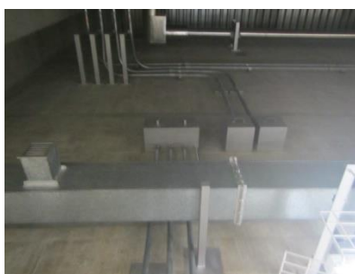
空調ダクト及び可とう電線管
