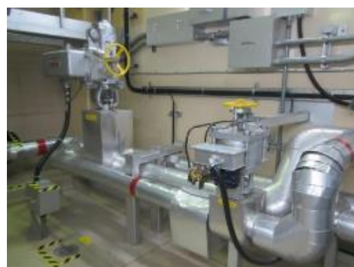
電動弁及び可とう電線管
