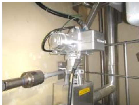
電動弁及び可とう電線管
