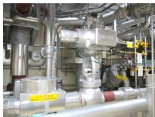
電動弁及び可とう電線管
