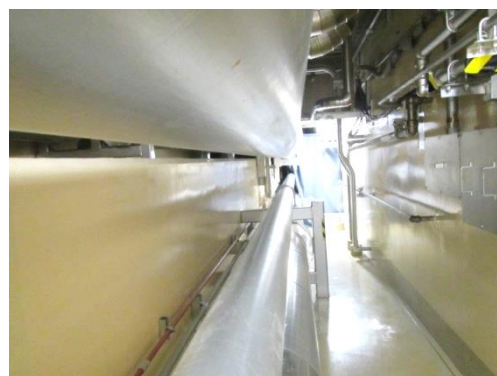
配管及び電線管
