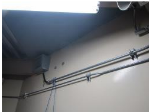
エリアモニタ及び可とう電線管
