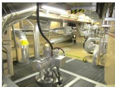
電動弁及び可とう電線管
