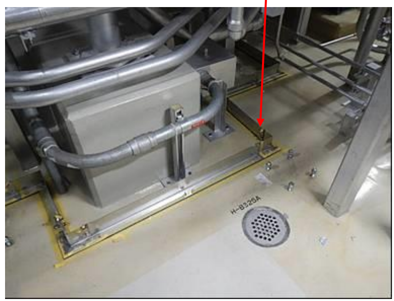
図 1 : 堰の設置状況
