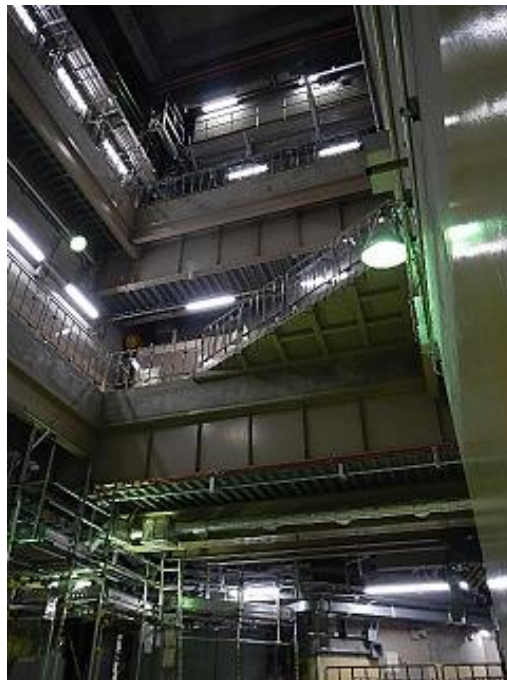
図2-5 7号炉原子炉建屋 2～3階 機器ハッチの状況
