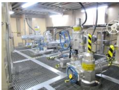
電動弁及び可とう電線管
