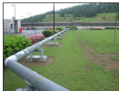
消火配管の地上化
