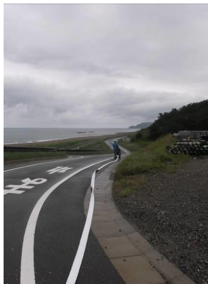
写真2 ホース展開状況
