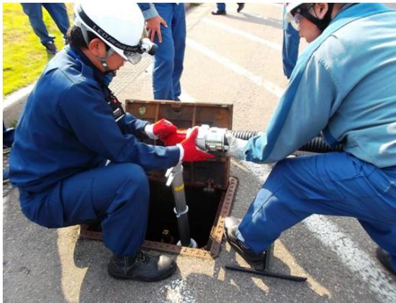
写真4 消火栓接続
