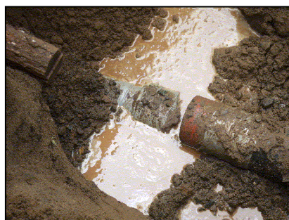
埋設消火配管の損傷
