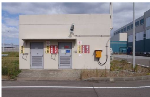
発電機用水素ガスボンベ建屋 (6号炉)
