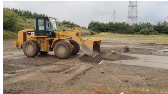
段差復旧状況②
