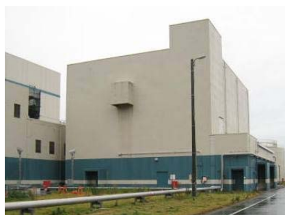
雑固体廃棄物焼却設備建屋 (大湊側)
