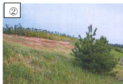
大湊側高台保管場所西側斜面（近景）
