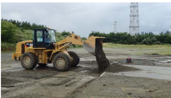
段差復旧状況①
