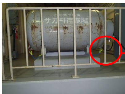
雑固体廃棄物焼却設備プロパン庫
