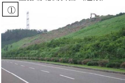
土捨場北側斜面（近景）
