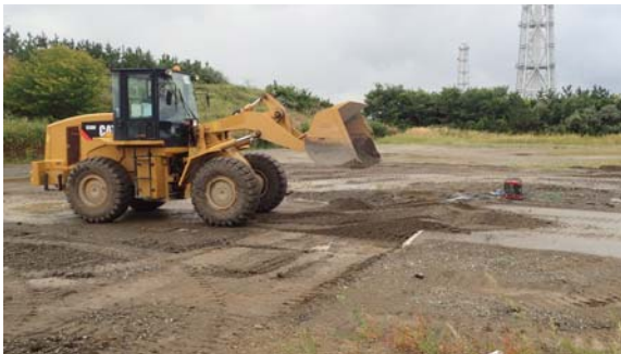
段差復旧状況③
