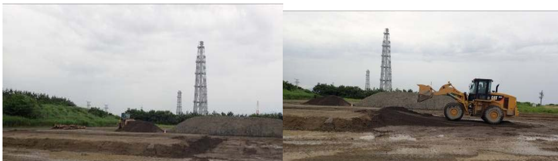
図6 段差復旧状況
