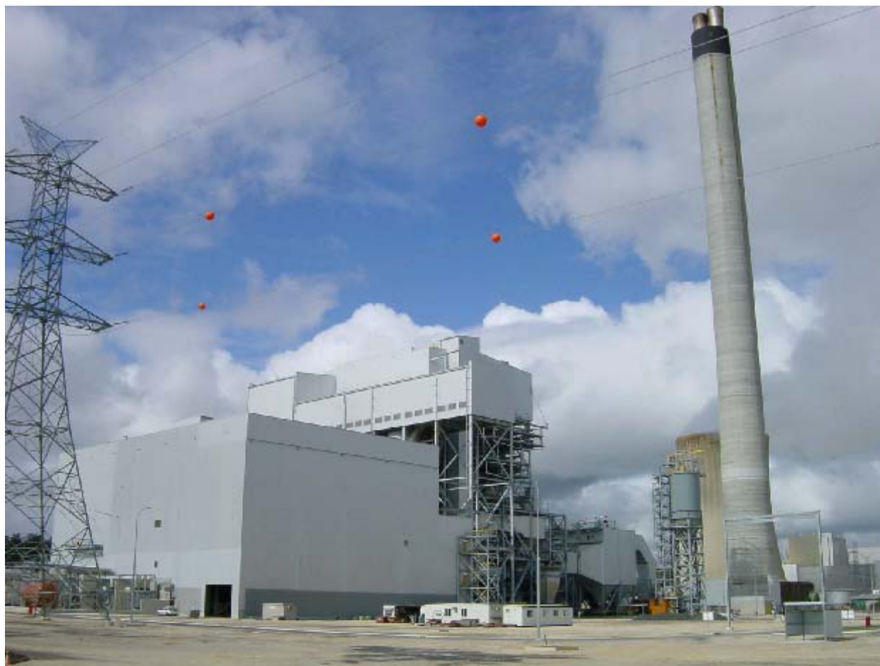
[ タロング・ノース発電所 ](石炭火力、出力 45 万 kW)
