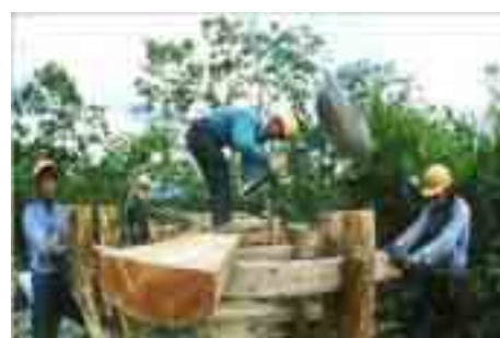
<木道掛替工事>
