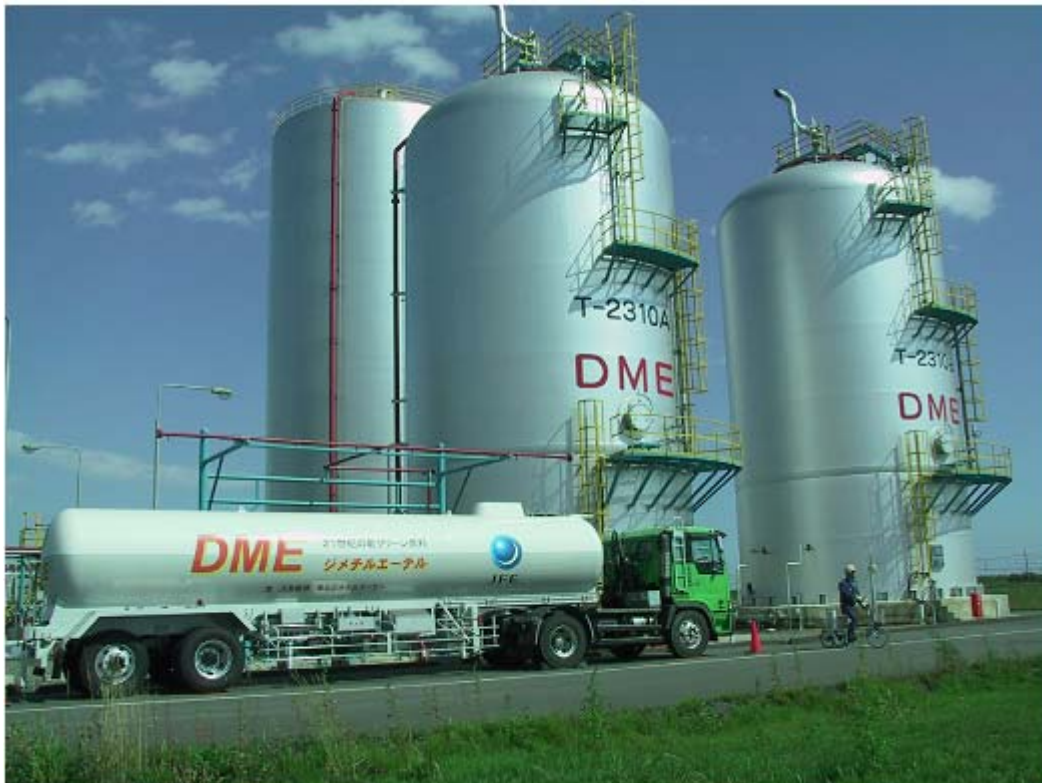
DME貯蔵タンクとDMEタンクトレーラー (DME実証プラント内)
